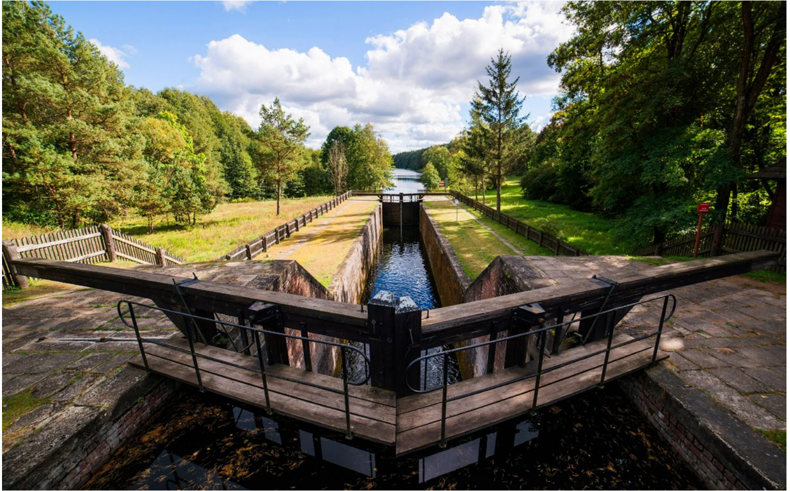
PL Dwukomorowa śluza Paniewo. EN Two-chamber Paniewo Lock. RU Двухкамерный шлюз Панево. Fot. Andrzej Sidor
