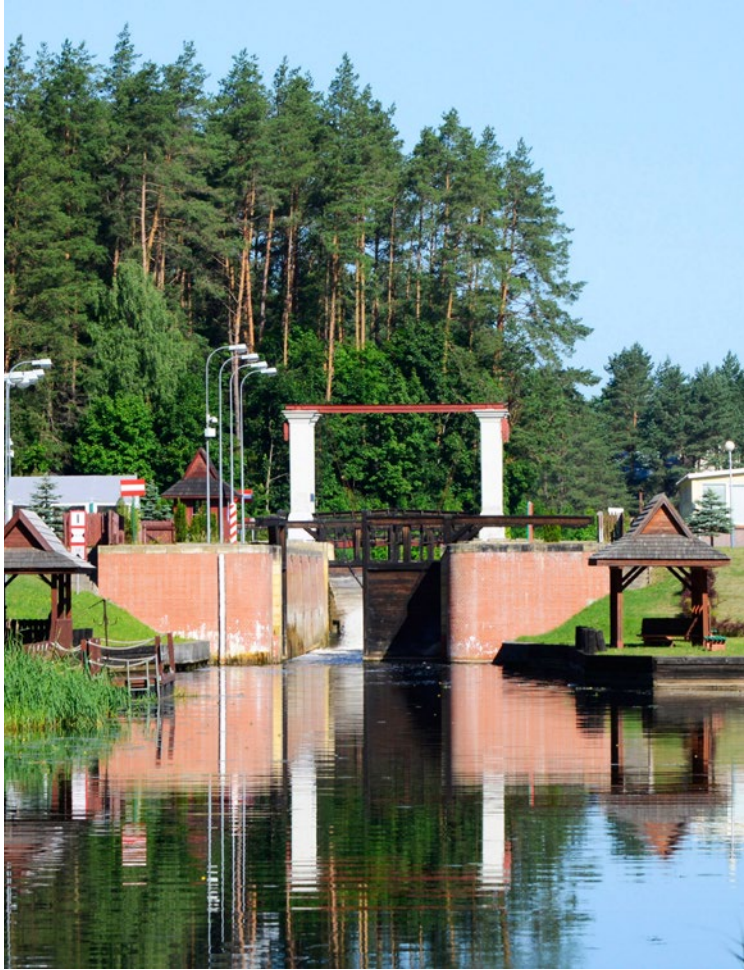
PL Śluza w Kurzyńcu. EN Kurzyniec Lock. RU Шлюз Кужинец. Fot. Andrzej Sidor
